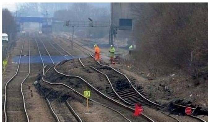
1-расм. Ер полотносини турли хил деформациялари
